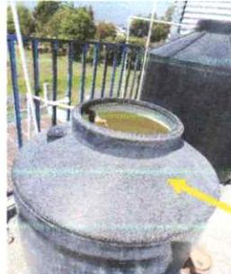
Por reparación reconexión de dos depositos de agua incluyendo sistema de flote nuevo, tapadera de deposito y filtros nuevos para limpieza de agua
