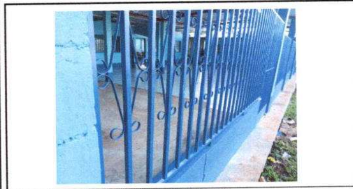
Foto 5: SUSTITUCIÓN DE BARANDAL DE METAL
