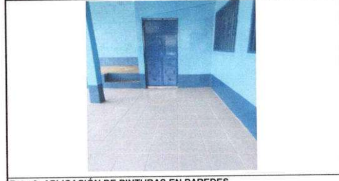
Foto 6: APLICACIÓN DE PINTURAS EN PAREDES
