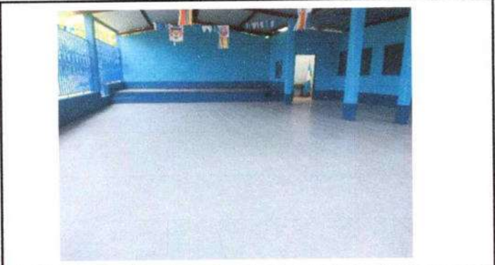
Foto1: SUSTITUCIÓN DE PISO DE CONCRETO POR CERÁMICO
