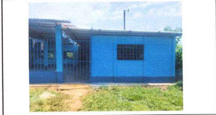
Foto 4: SUSTITUCIÓN DE LÁMINA ACANALADA POR TROQUELADA C 26
