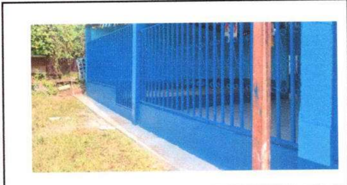
Foto 3: MANTENIMIENTO DE TORTA DE CONCRETO.
