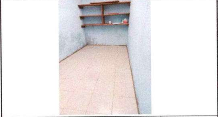
Foto 2: SUSTITUCIÓN DE PISO CONCRETO POR CERÁMICO
