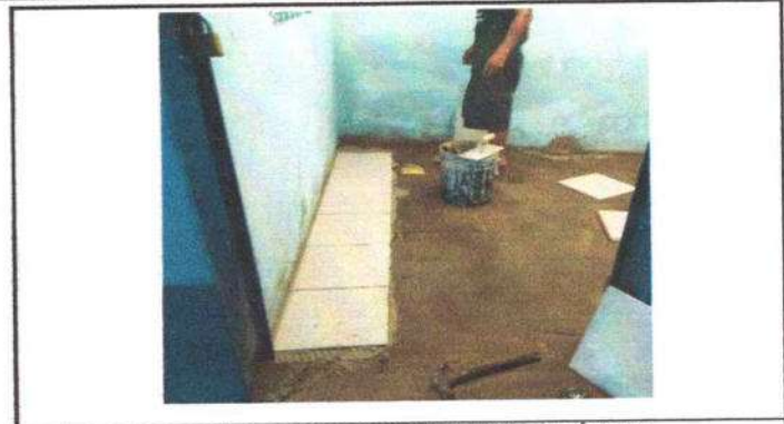
Foto 2: SUSTITUCIÓN DE PISO CONCRETO POR CERÁMICO
