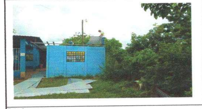
Foto 4: SUSTITUCIÓN DE LÁMINA ACANALADA POR TROQUELADA C 26
