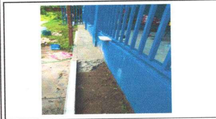
Foto 3: MANTENIMIENTO DE TORTA DE CONCRETO.
