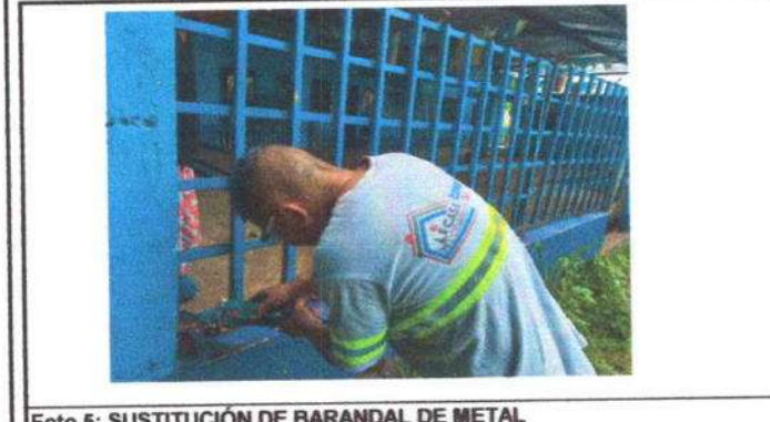
Foto 5: SUSTITUCIÓN DE BARANDAL DE METAL
