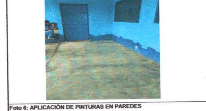
Foto 6: APLICACIÓN DE PINTURAS EN PAREDES
