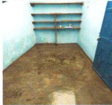
Foto 2: SUSTITUCIÓN DE PISO CONCRETO POR CERÁMICO
