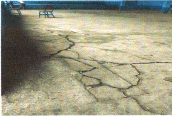
Foto 1: SUSTITUCIÓN DE PISO DE CONCRETO POR CERÁMICO
