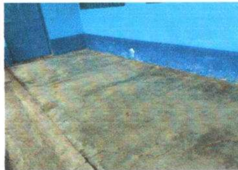
Foto 6: APLICACIÓN DE PINTURAS EN PAREDES.
