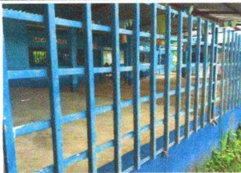
Foto 5: SUSTITUCIÓN DE BARANDAL DE METAL
