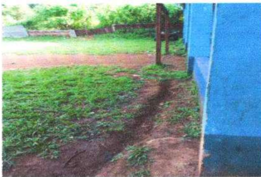
Foto 3: MANTENIMIENTO DE TORTA DE CONCRETO.
