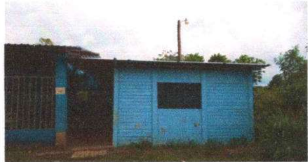
Foto 4: SUSTITUCIÓN DE LÁMINA ACANALADA POR TROQUELADA C 26
