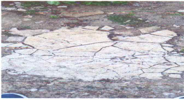
SUMINISTRO Y SUSTITUCION DE PISO DE TORTA DE CONCRETO EN COCINA
