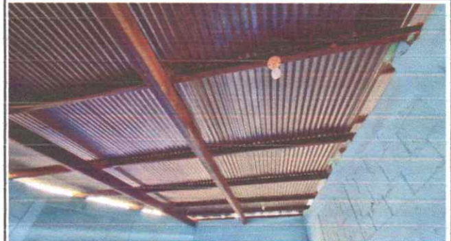
SUMINISTRO Y REPARACION DE SISTEMA ELECTRICO
