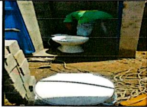
FOTO 14: INSTALACION DE SANITARIOS LAVABLES
