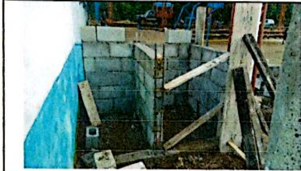
FOTO 13: REPARACION DE MURO Y DRENAJE EN SANITARIOS LAVABLES
