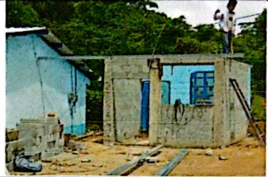
FOTO 8: SUSTITUCION DE TECHO DE LAMINA EN COCINA Y AMPLIACION DE TECHO DE LAMINA
