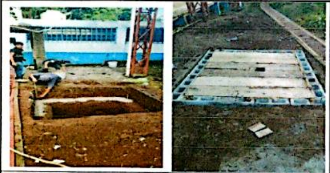
FOTO 16: INSTALACION DE FOSA SÉPTICA CON BROCAL Y TAPADERA
