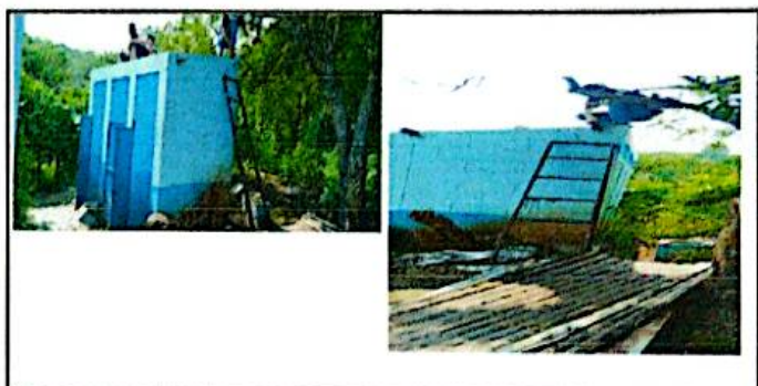
FOTO 4: SUSTITUCION DE TECHO DE LAMINA EN SANITARIO
