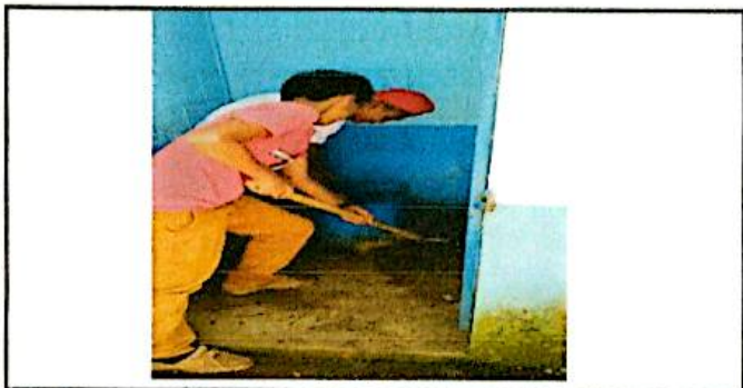
FOTO 3: INSTALACION DE 3 SANITARIOS TIPO LETRINA
