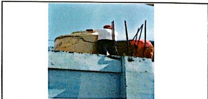
FOTO 6: INSTALACION DE DEPÓSITO DE AGUA
