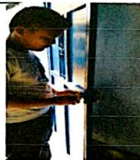
FOTO 12: SUSTITUCION DE CHAPA EN PUERTA DE METAL EN COCINA
