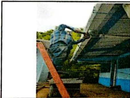
FOTO 17: REPARACION DE BAJADA PLUVIAL
