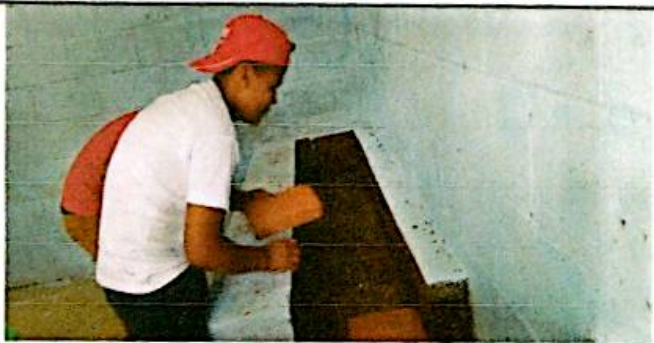
FOTO 9: SUSTITUCION DE BASE DE ESTUFA RURAL EN COCINA
