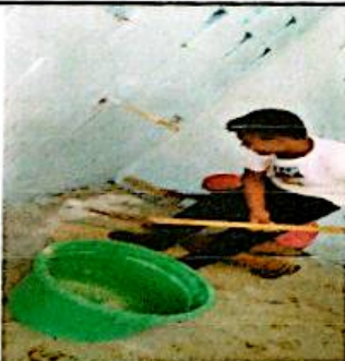
FOTO 11: SUSTITUCION DE TORTA DE CONCRETO EN COCINA
