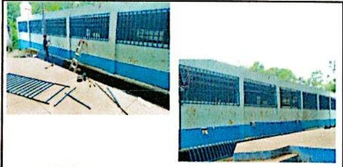
FOTO 5: SUSTITUCION Y REPARACION DE BALCONES DE METAL
