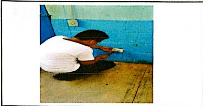
FOTO 1: REPARACION DE SISTEMA ELECTRICO EN 4 AULAS Y COCINA
