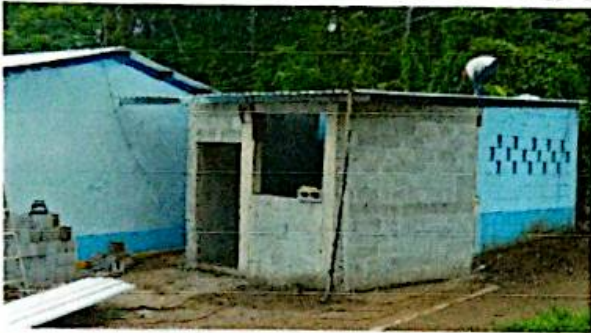
FOTO 7: SUSTITUCION DE MURO DE CONCRETO E INSTALACION DE MESA DE CONCRETO EN COCINA
