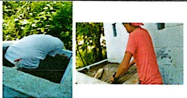
FOTO 10: INSTALACION DE TANQUE CON LAVADERO EN AREA DE COCINA
