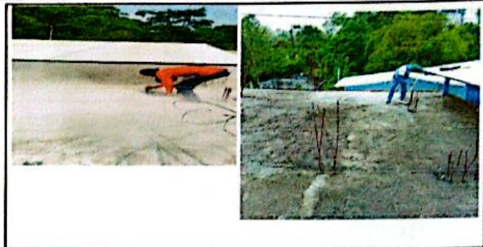
FOTO 2: IMPERMEABILIZACION DE LOZA DE CONCRETO EN 4 AULAS
