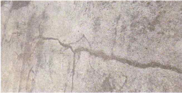
Foto7: Impermeabilizacion de loza
