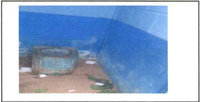
Foto 14: Sustitución de sanitarios
