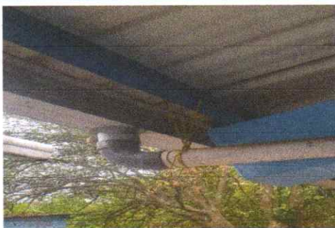
Foto 5: Canales y bajadas de agua pluvial
