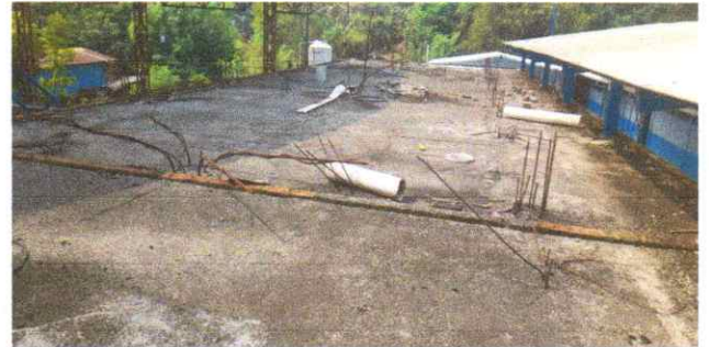
Foto8: Impermeabilizacion de loza
