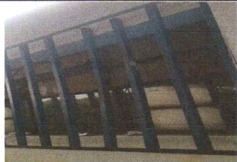
Foto 12: Ventanas y balcones
