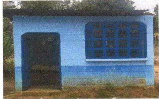
Foto 2: REPARACION DE TECHO DE LAMINA Y COSTANERAS (ESTRUCTURA MET)
