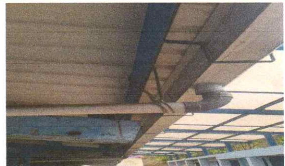
Foto 6: Canales y bajadas de agua pluvial
