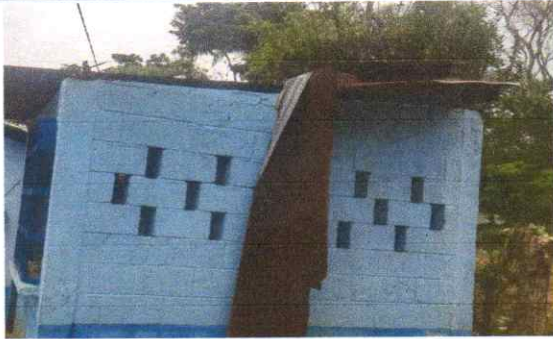
Foto 1: REPARACION DE TECHO DE LAMINA Y COSTANERAS (ESTRUCTURA MET)
