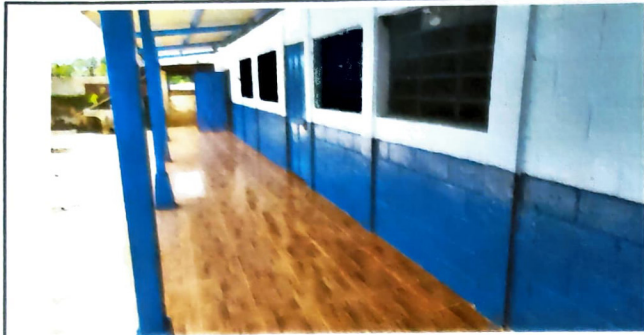
Foto 7: SUSTITUCIÓN DE TORTA DE CONCRETO POR PISO CERAMICO
