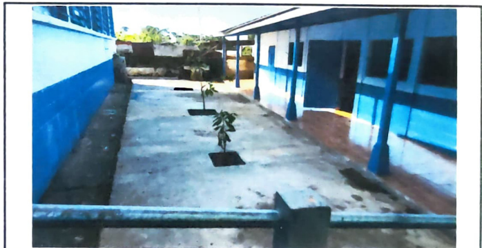
Foto 4: Sustitución de torta de concreto por concreto
