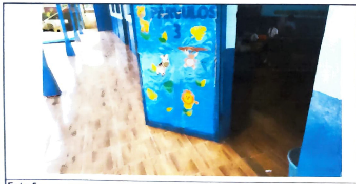
Foto 5: Instalación de piso cerámico
