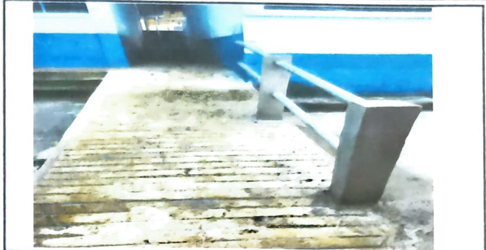
Foto 2: Sustitución de rampas 2 de concreto
