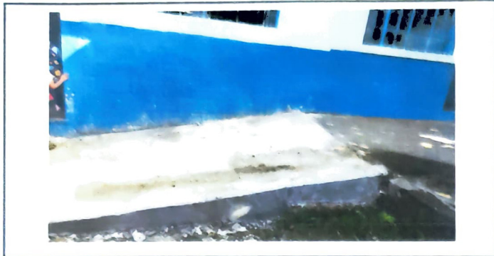
Foto 1: Sustitución de rampas de concreto
