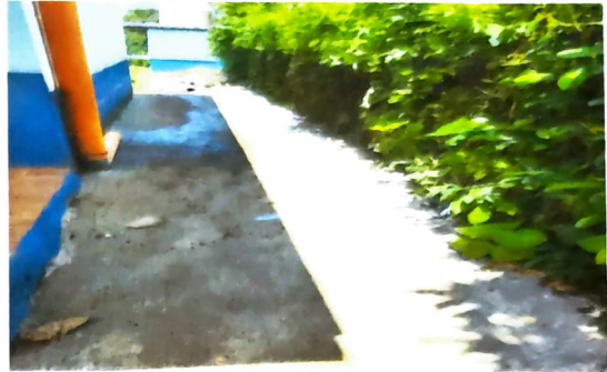
Foto 8: SUSTITUCIÓN DE TORTA DE PIEDRA POR TORTA DE CONCRETO
