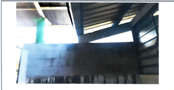
Foto 3: Reparación Muro perimetral
