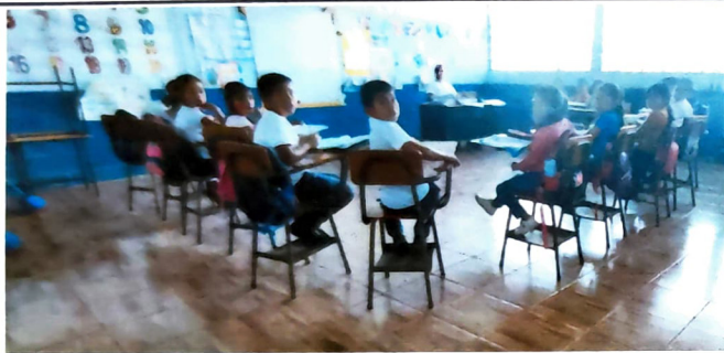
Foto 9: SUSTITUCIÓN DE PISO DE CONCRETO POR PISO CERÁMICO CON BASE DE CONCRETO, módulo 3
