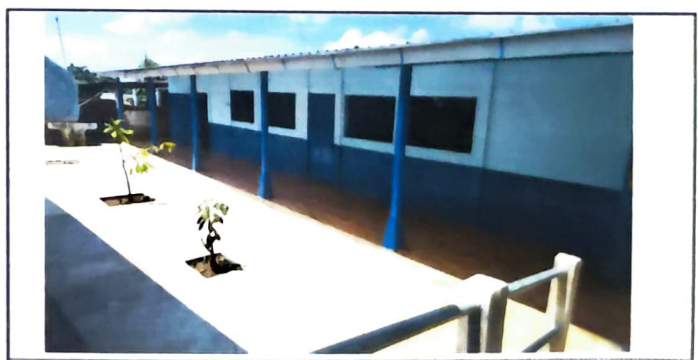
Foto 6: Instalación de ventanas
