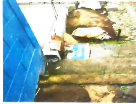
Foto 2: Sustitución de rampas 2 de concreto
