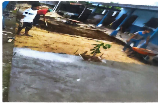
Foto 4: Sustitución de torta de concreto por concreto
