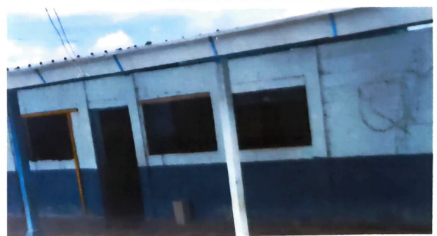
Foto 6: Instalación de ventanas
