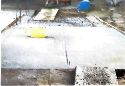
Foto 1: Sustitución de rampas de concreto
