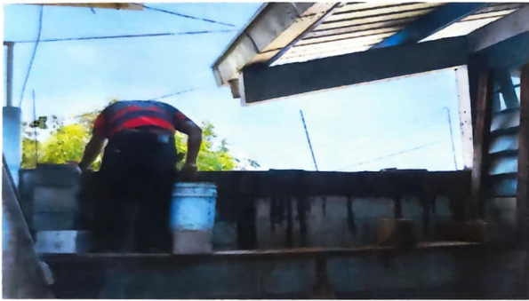
Foto 3: Reparación Muro perimetral
