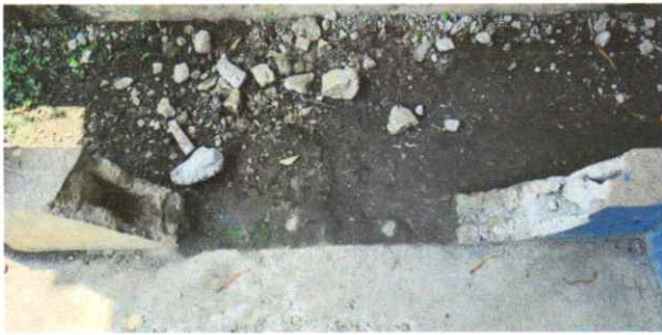
SUMINISTRO E INSTALACIÓN MURO PERIMETRAL
