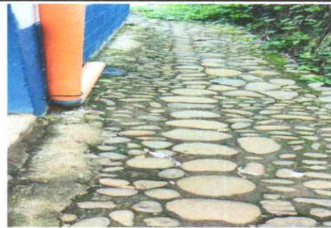
SUMINISTRO E INTALACIÓN DE TORTA DE CEMENTO
