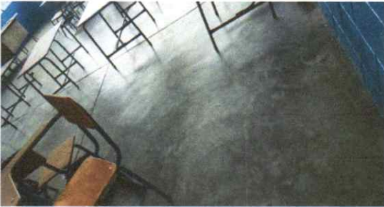
SUSTITUCIÓN DE TORTA DE CONCRETO POR PISO CERAMICO
