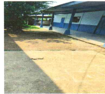
SUMINISTRO E INSTALACIÓN DE TORTA DE CONCRETO
