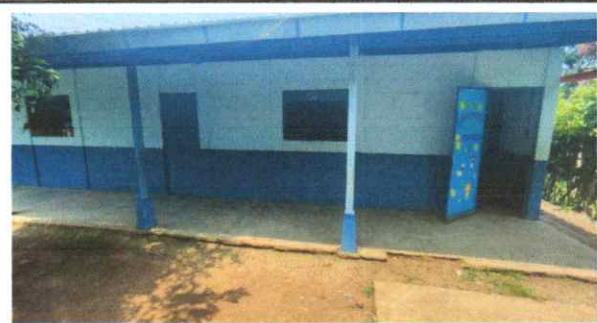
SUMINISTRO E INSTALACIÓN DE VENTANAS
