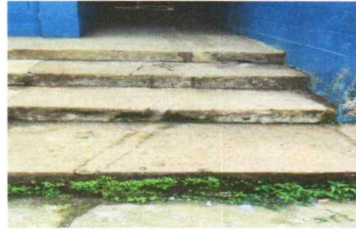
SUMINISTRO E INSTALACIÓN DE RAMPAS DE ACCESO
