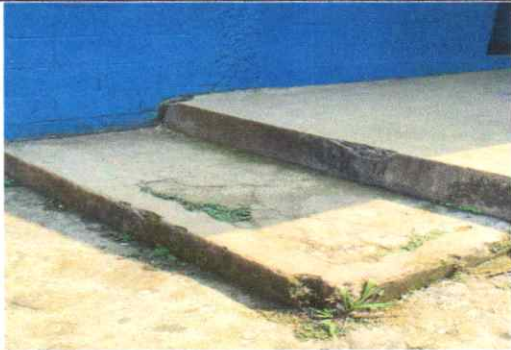
SUMINISTRO E INSTALACIÓN DE RAMPAS DE ACCESO
