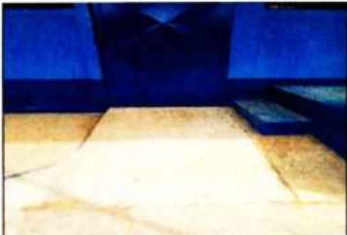
Foto 11: Sustrucción de rampas de acceso en 3 aulas
