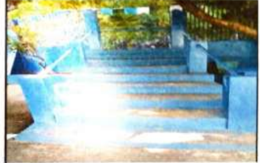
Foto 8: Reparación de gradas de entrada principal
