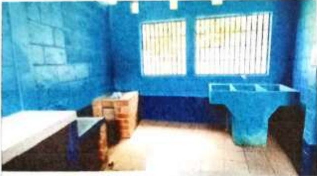
Foto 1: Reparación y mantenimiento de cocina
