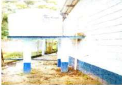
Foto 7: Sustrucción de depósito de agua y bomba
