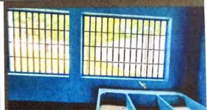
Foto 4: Sustitución de balcones de metal en cocina
