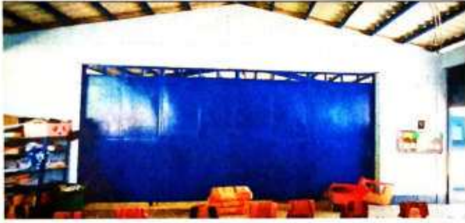
Foto 9: Reparación en 4 puertas abatibles en aula
