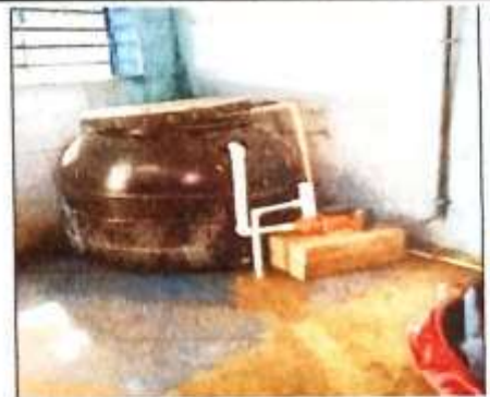
Foto 6: Sustitución de bomba para depósito de agua
