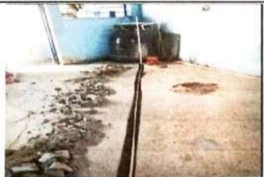
Foto 6: Sustitución de bomba para depósito de agua
