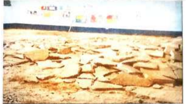
Foto 2: Sustitución de piso de concreto en aula
