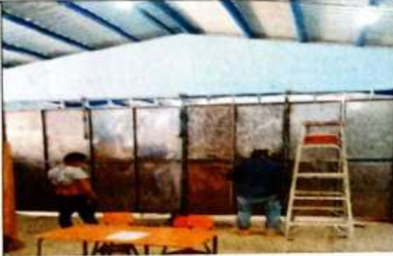
Foto 9: Reparación en 4 puertas abatibles en aula
