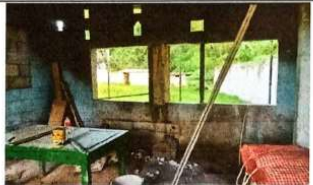
Foto 4: Sustitución de balcones de metal en cocina
