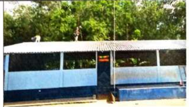
Foto 10: Mantenimiento de estructura de metal en 2 aulas y cambio de tornillos de techo en 4 aulas
