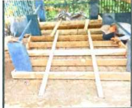
Foto 8: Reparación de gradas de entrada principal
