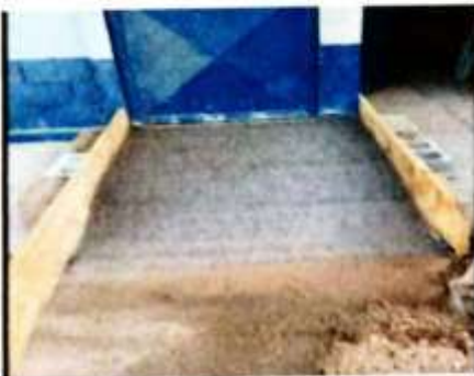
Foto 11: Sustitución de rampas de acceso en 3 aulas
