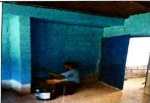
Foto 5: Aplicación de pintura en paredes de cocina
