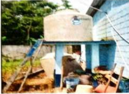
Foto 7: Sustitución de depósito de agua y bomba
