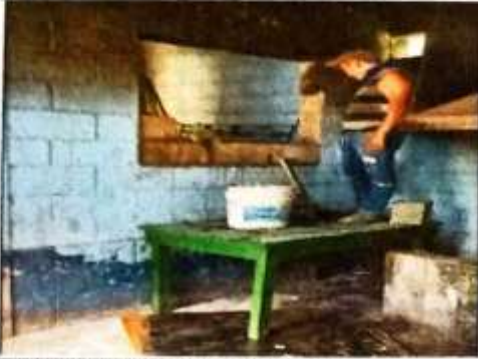
Foto 1: Reparación y mantenimiento de cocina
