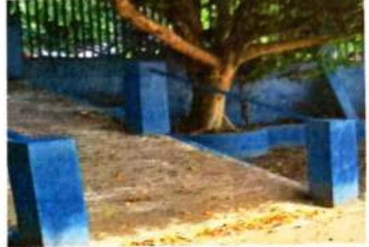
Foto 8: Reparación de gradas de entrada principal
