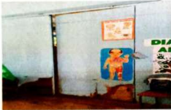
Foto 9: Reparación en 4 puertas abatibles en aula
