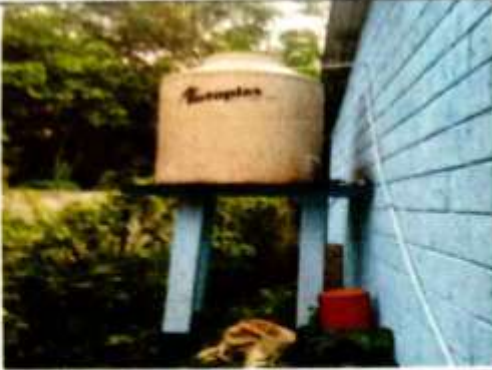
Foto 7: Sustitución de depósito de agua y bomba
