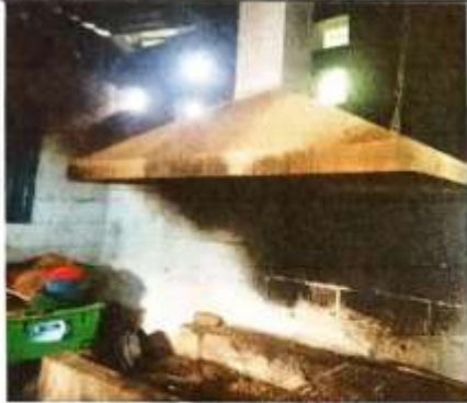
Foto 1: Reparación y Mantenimiento de cocina
