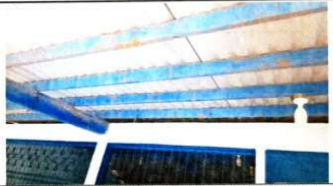
Foto 10: Mantenimiento de estructura de metal en 2 aulas y cambio de tornillos de techo en 4 aulas
