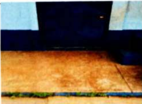
Foto 11: Sustitución de rampas de acceso en 3 aulas
