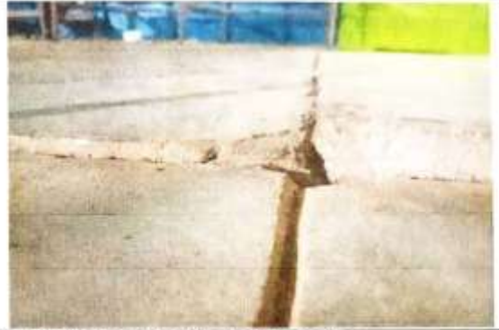
Foto 2: Sustitución de piso de concreto en aula
