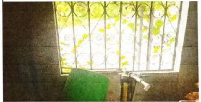
Foto 4: Sustitución de balcones de metal en cocina
