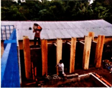
Foto1: SUSTITUCION DE MURO DE BLOCK EN SANITARIOS
