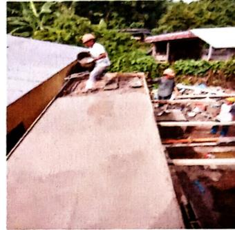
Foto 2: SUSTITUCION DE LOSA EN SANITARIOS
