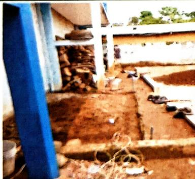
Foto 5: SUSTITUCION DE PLANCHA DE CONCRETO
