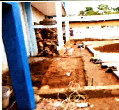
Foto 5: SUSTITUCION DE PLANCHA DE CONCRETO
