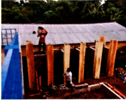
Foto1: SUSTITUCION DE MURO DE BLOCK EN SANITARIOS
