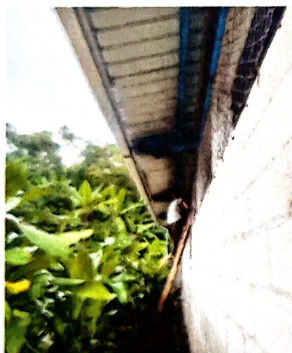
Foto 3: SUSTITUCION DE CANAL
