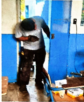
Foto1: REPARACION DE PUERTA DE METAL
