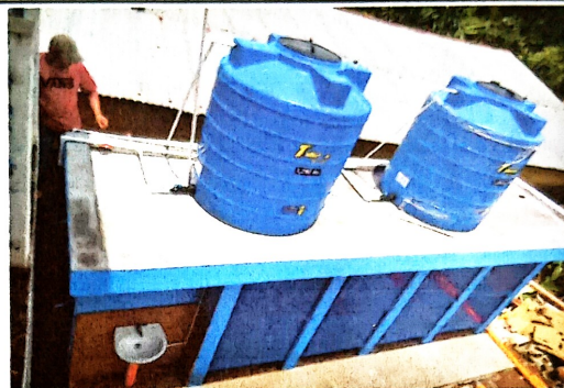
Foto 2: SUSTITUCION DE DEPOSITO DE AGUA EN SANITARIOS
