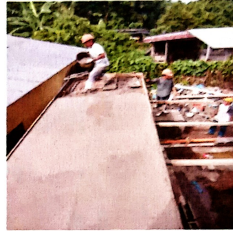
Foto 2: SUSTITUCION DE LOSA EN SANITARIOS
