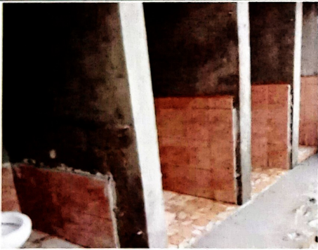
Foto 3: SUSTITUCION DE AZULEJOS EN SANITARIOS
