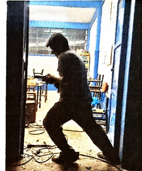
Foto 2: REPARACION DE PUERTA DE METAL
