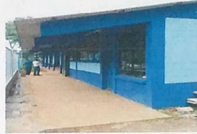
FOTO 2: APLICACIÓN DE PINTURA
