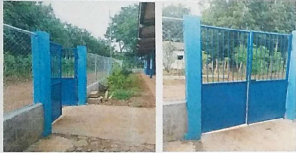
FOTO 1: SUSTITUCION DE PORTON
