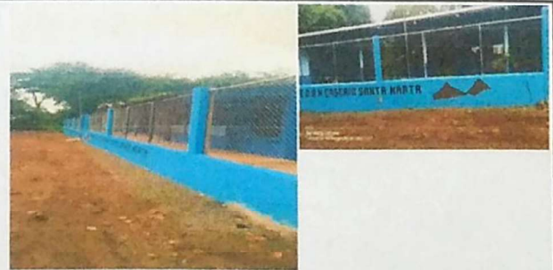
FOTO 6: INSTALACION DE MALLA EN MURO PERIMETRAL
