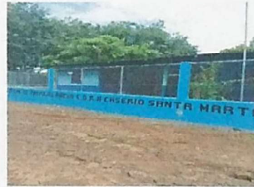
FOTO 4: REPARACION DE MURO PERIMETRAL Y SUSTITUCION DE MALLA
