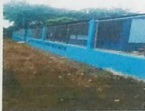
FOTO 5: INSTALACION DE MALLA EN MURO PERIMETRAL
