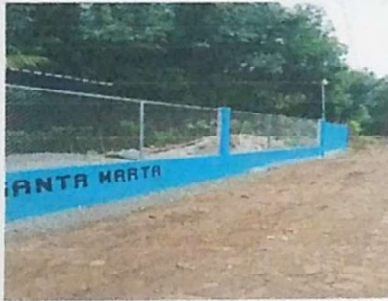
FOTO 3: REPARACIÓN DE MURO PERIMETRAL Y SUSTITUCION DE MALLA
