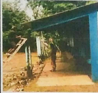
FOTO 1: SUSTITUCION DE PORTON
