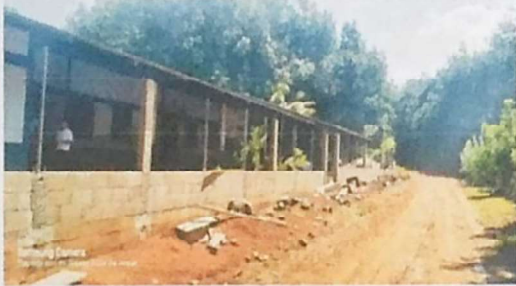
FOTO 3: REPARACIÓN DE MURO PERIMETRAL Y SUSTITUCION DE MALLA
