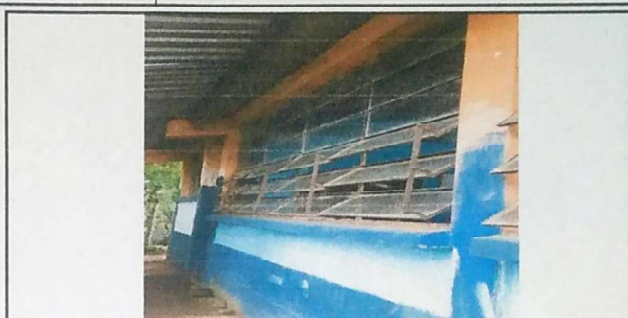
FOTO 2: APLICACIÓN DE PINTURA
