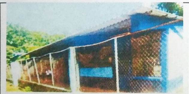
FOTO 5: SUSTITUCION DE MALLA EN MURO PERIMETRAL
