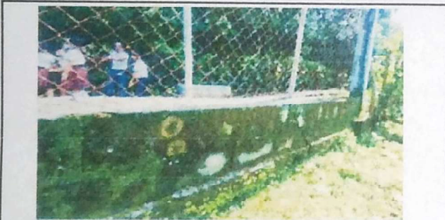
FOTO 3: SUSTITUCION DE MURO DE CONCRETO PERIMETRAL
