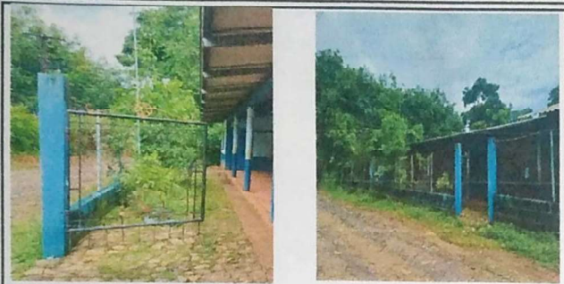
FOTO 1: SUSTITUCION DE PORTON
