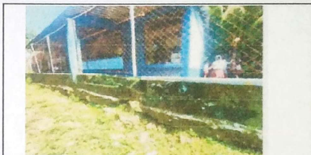
FOTO 4: SUSTITUCION DE MURO DE CONCRETO PERIMETRAL
