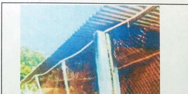
FOTO 6: SUSTITUCION DE MALLA EN MURO PERIMETRAL
