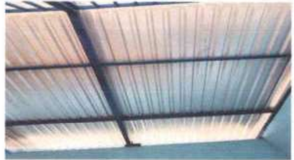
FOTO 2: SUMINISTRO Y SUSTITUCION DE LAMINA POR LAMINA TROQUELADA CALIBRE 26
