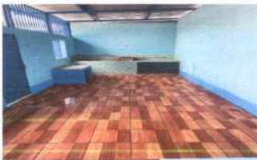
FOTO 5: SUMINISTRO Y SUSTITUCION DE TORTA DE CONCRETO POR PISO CERAMICO
