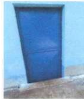
FOTO 4: SUMINISTRO Y REPARACION DE PUERTA DE METAL
