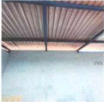
FOTO 1: SUMINISTRO Y SUSTITUCION DE ESTRUCTURA DE METAL POR METAL
