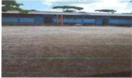
FOTO 7: SUMINISTRO Y SUSTITUCION DE LOSA DE PATIO
