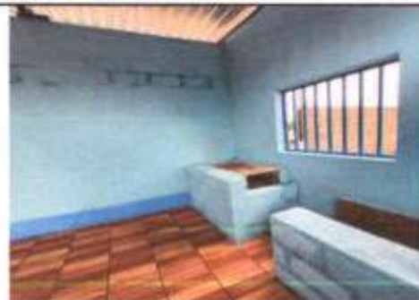
FOTO 6: MANTENIMIENTO DE MUROS DE COCINA
