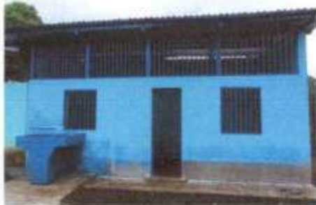
FOTO 3: SUMINISTRO Y SUSTITUCION DE BALCONES EN COCINA
