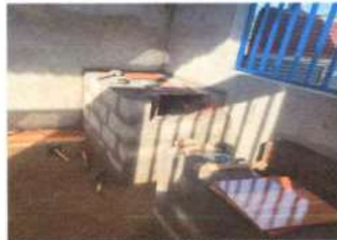
FOTO 6: MANTENIMIENTO DE MUROS DE COCINA
