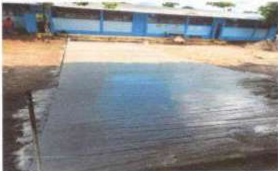
FOTO 7: SUMINISTRO Y SUSTITUCION DE LOSA DE PATIO
