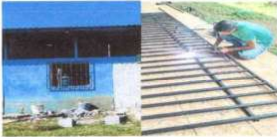
FOTO 3: SUMINISTRO Y SUSTITUCION DE BALCONES EN COCINA
