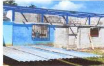
FOTO 2: SUMINISTRO Y SUSTITUCION DE LAMINA POR LAMINA TROQUELADA
