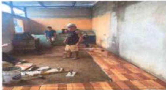
FOTO 5: SUMINISTRO Y SUSTITUCION DE TORTA DE CONCRETO POR PISO CERAMICO
