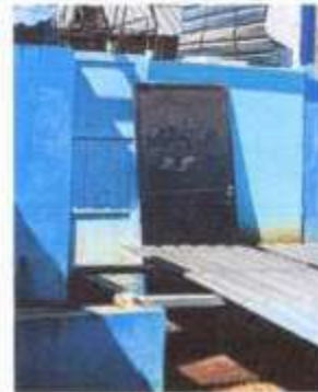
FOTO 4: SUMINISTRO Y REPARACION DE PUERTA DE METAL
