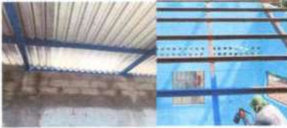
FOTO 1: SUMINISTRO Y SUSTITUCION DE ESTRUCTURA METAL POR METAL
