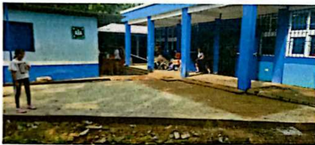
Foto 3: SUSTITUCION DE ÁREA POR TORTA DE CONCRETO
