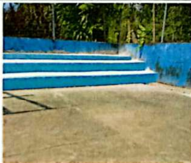
Foto 5: REPARACION DE GRADAS DE CONCRETO EN CANCHA
