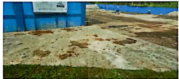
Foto 4: SUSTITUCION DE ÁREA POR TORTA DE CONCRETO
