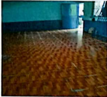
Foto 1: SUSTITUCION DE PISO POR PISO CERÁMICO
