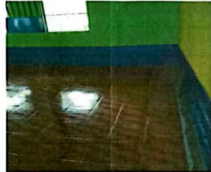
Foto 2: SUSTITUCION DE PISO POR PISO CERÁMICO
