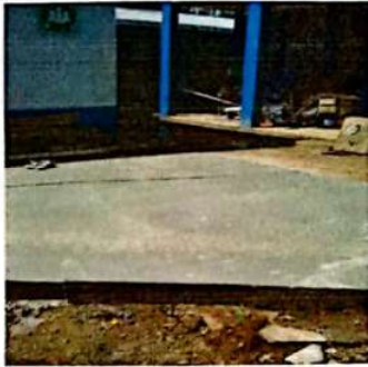
Foto 3: SUSTITUCION DE ÁREA POR TORTA DE CONCRETO
