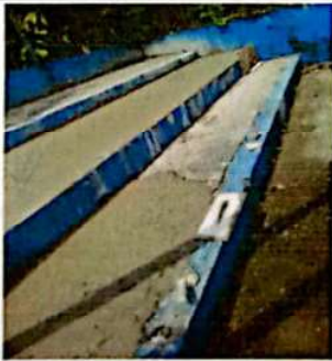
Foto 5: REPARACION DE GRADAS DE CONCRETO EN CANCHA
