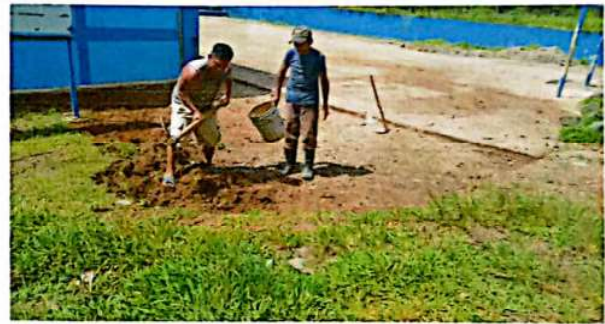
Foto 4: SUSTITUCION DE ÁREA POR TORTA DE CONCRETO
