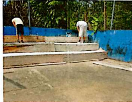
Foto 6: REPARACION DE GRADAS DE CONCRETO EN CANCHA
