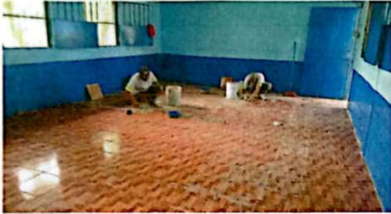
Foto 1: SUSTITUCION DE PISO POR PISO CERÁMICO
