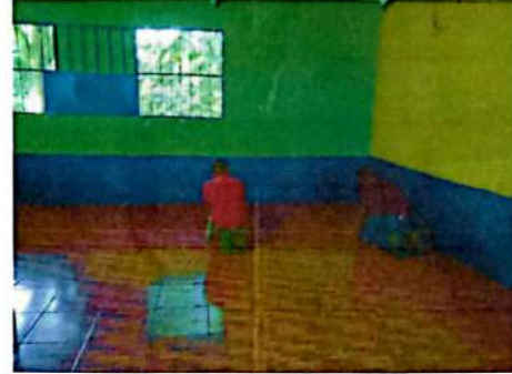
Foto 2: SUSTITUCION DE PISO POR PISO CERÁMICO
