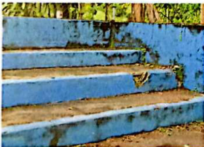
Foto 5: REPARACION DE GRADAS DE CONCRETO EN CANCHA
