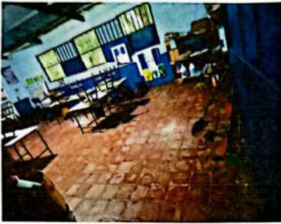
Foto 1: SUSTITUCION DE PISO POR PISO CERÁMICO
