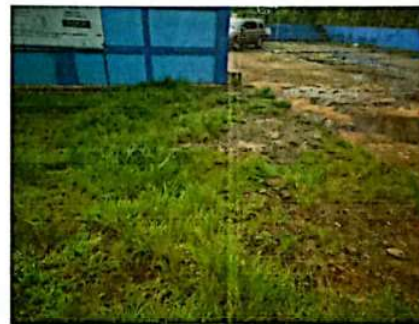
Foto 4: SUSTITUCION DE ÁREA POR TORTA DE CONCRETO
