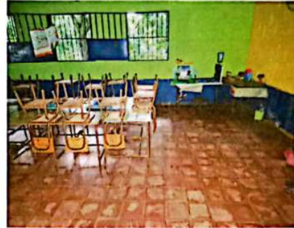
Foto 2: SUSTITUCION DE PISO POR PISO CERÁMICO
