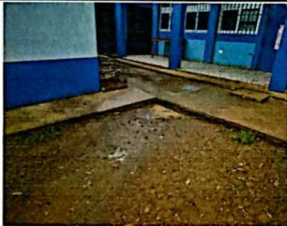
Foto 3: SUSTITUCION DE ÁREA POR TORTA DE CONCRETO
