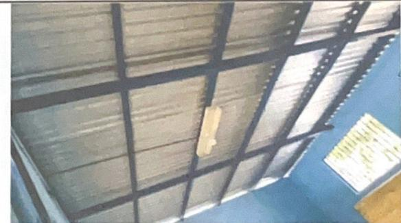
Foto 6: SUSTITUCIÓN DE CUBIERTA DE LÁMINA POR LÁMINA ALUZINC C 26
