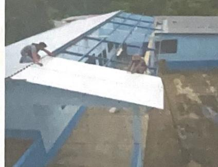
Foto 6: SUSTITUCIÓN DE CUBIERTA DE LÁMINA POR LÁMINA ALUZINC TROQUELADA C 26
