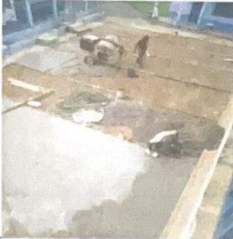
Foto1: SUSTITUCION DE TORTA DE CONCRETO EN PATIO
