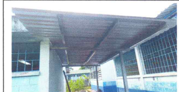
Foto 4: Mantenimiento de estructura para soporte de lámina
