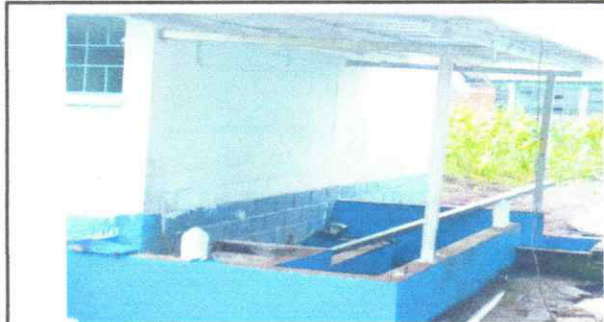
FOTO 9 : APLICACIÓN DE PINTURA EN PARED (area de lavaderos )
