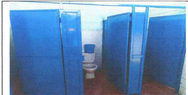
Foto 12: SUSTITUCION DE DIVISION DE METAL EN SANITARIO
