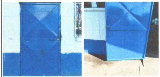
Foto 10: INSTALACION DE CHAPAS EN PUERTAS DE METAL
