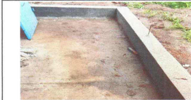
foto 3 : Instalacion de muro de concreto
