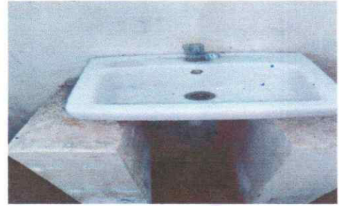
FOTO 8 : SUSTITUCION DE ACCESORIOS PARA SANITARIOS Y LAVAMANOS
