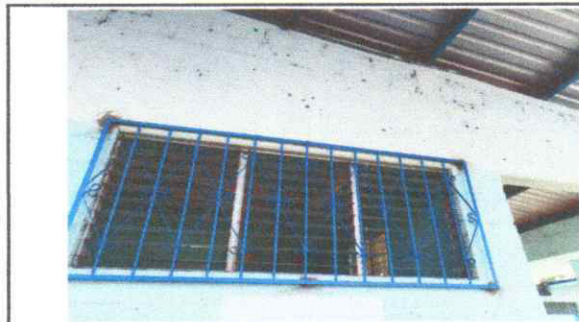
Foto 11: FABRICACION E INSTALACION DE DE BALCONES DE METAL
