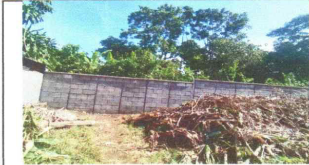
Foto 1: Instalacion de muro perimetral pre-fabricado
