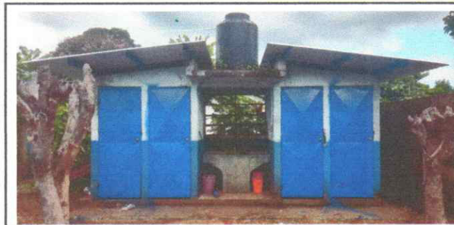
Foto 5: Instalacion de lamina troquelada calibre 26
