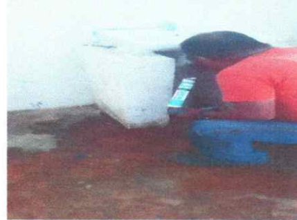
FOTO 8 : SUSTITUCION DE ACCESORIOS PARA SANITARIOS
