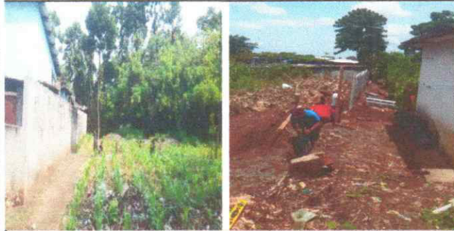
Foto 1: Instalacion de muro perimetral pre-fabricado
