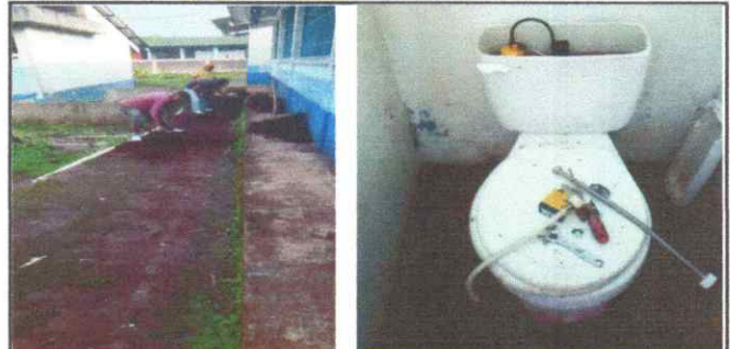
Foto 6: Instalacion de tuberia en servicios de sanitarios, sustitucion de accesorios para sanitarios
