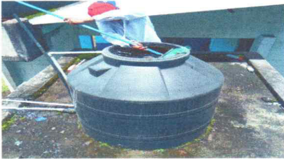
Foto 13: INSTALACION DE DEPÓSITO DE AGUA DE 1100 LITROS CON SUS ACCESORIOS
