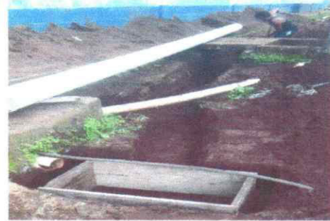
Foto 2: Instalacion de drenaje aguas pluviales con cajas de registro
