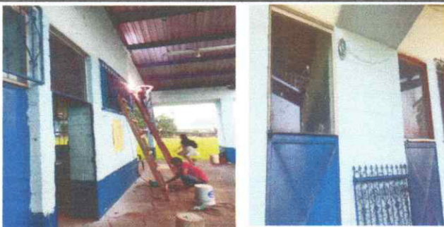
Foto 11: FABRICACION E INSTALACION DE DE BALCONES DE METAL
