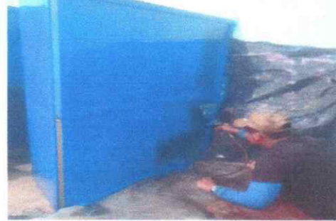
Foto 14: APLICACIÓN DE PINTURA TIPO ANTIFORRO EN PARED DE SANITARIOS
