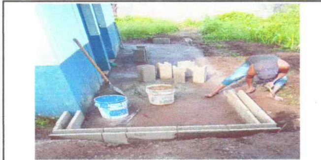
foto 3 : Instalacion de muro de concreto
