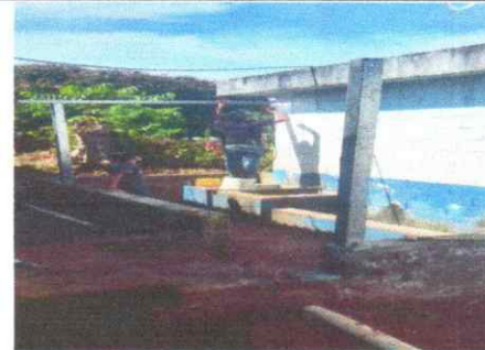
Foto 4: Mantenimiento de estructura para soporte de lámina
