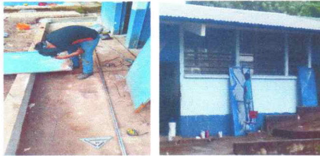
Foto 7: MANTENIMIENTO DE PUERTAS DE METAL, APLICACIÓN DE PINTURA.
