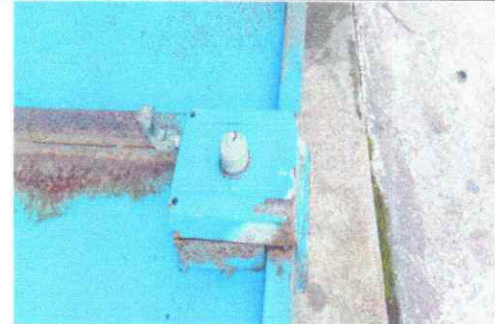
Foto 10: INSTALACION DE CHAPAS EN PUERTAS DE METAL
