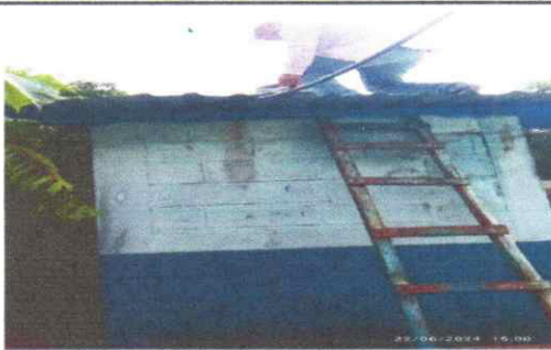
Foto 5: Instalacion de lamina troquelada calibre 26
