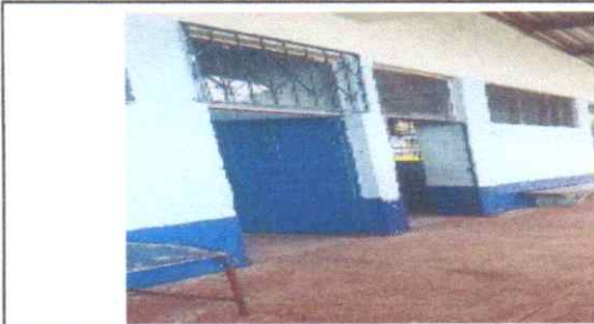
11. Instalación de balcones de metal
