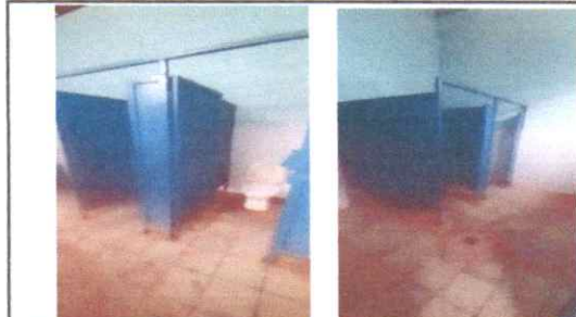
11. Sustitución de puertas de metal
