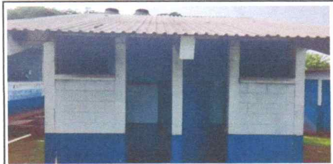
6. Reparación de sanitarios
