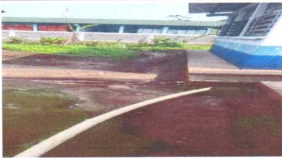
3. Instalación de drenaje
