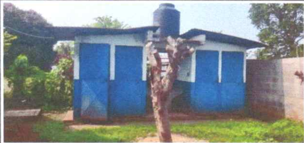
7. Reparación de puertas, sustitución lámina
