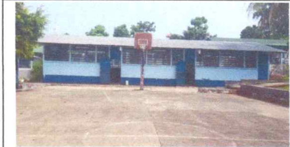
10. Mantenimiento puertas de metal
