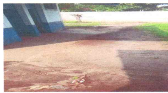
4. Instalación de muro
