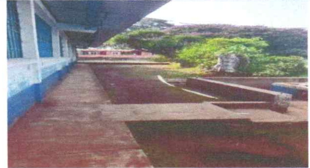
2. Instalación drenaje para aguas pluviales con cajas de registro
