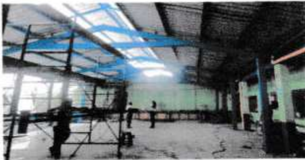
Foto 3: Sustitución de base de estructura para cubierta lamina
