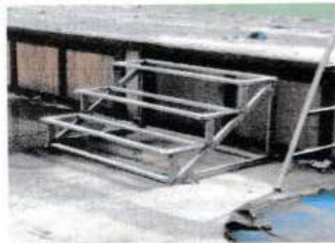
Foto 4: Sustitucion de gradas de madera por metal.
