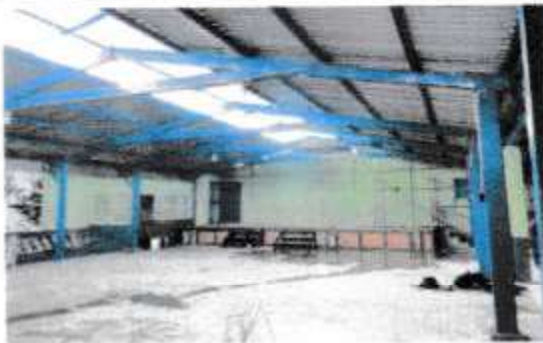
Foto 5: Mantenimiento a sistema electrico de salón
