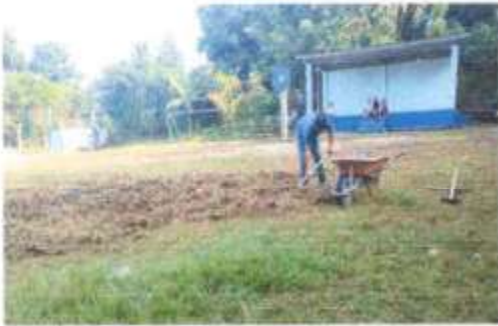
Foto 3: SUSTITUCION DE TORTA DE CONCRETO EN PATIO
