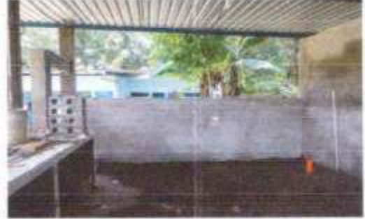
Foto 2: SUSTITUCION DE PISO DE CONCRETO DE COCINA POR PISO LISO.
