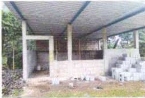
Foto 5: SUSTITUCION DE BALCONES EN COCINA.
