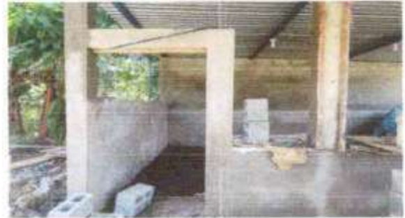
Foto 4: SUSTITUCION DE PUERTA DE MADERA POR METAL EN COCINA.
