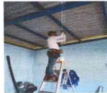
Foto 6: REPARACIÓN DE SISTEMA ELECTRICO
