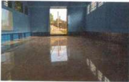
Foto1: SUMINISTRO E INSTALACIÓN DE PISO CERÁMICO
