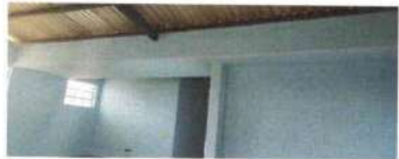
Foto 4: APLICACIÓN DE PINTURA LATEX CLASICA
