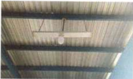
Foto 3: SUSTITUCION DE BOMBILLAS LIGH TECH 40WTTTS
