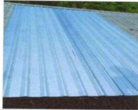
Foto 2: SUSTITUCIÓN DE LAMINA TROQUELADA ALUZIN C26
