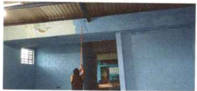
Foto 4: APLICACIÓN DE PINTURA LATEX CLASICA
