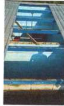
Foto 2: SUSTITUCIÓN DE LAMINA TROQUELADA ALUZIN C26
