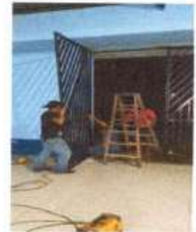
Foto 6: SUMINISTRO Y SUSTITUCION DE PORTON DE METAL
