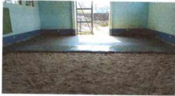
Foto 1: SUMINISTRO E INSTALACIÓN DE PISO CERÁMICO
