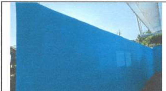
Foto 4: Mantenimiento de muro perimetral
