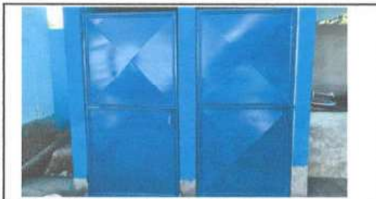
Foto 5: Sustitución de puertas metálicas de sanitario
