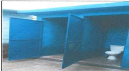
Foto 1: Suministro y sustitución de sanitarios
