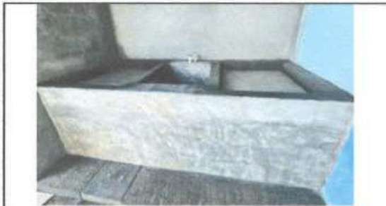
Foto 3: Suministro y sustitución de pila
