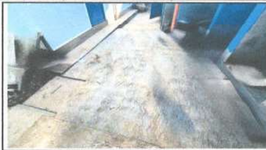
Foto 2: Reparación de Losa de Concreto de patio
