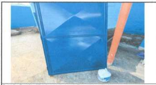
Foto 5: Sustitución de puertas metálicas de sanitario
