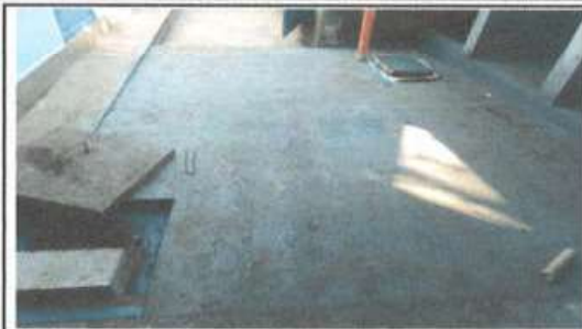
Foto 2: Reparación de losa de concreto de patio
