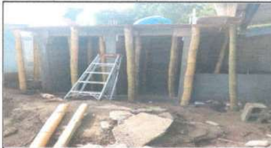
Foto 1: Suministro y sustitución de sanitarios
