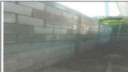
Foto 4: Mantenimiento de muro perimetral
