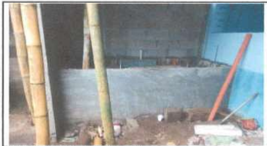
Foto 3: Suministro y sustitución de pila
