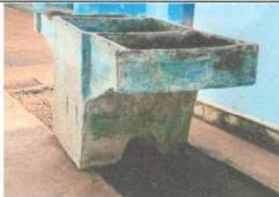
Foto 3: Suministro y sustitución de pila
