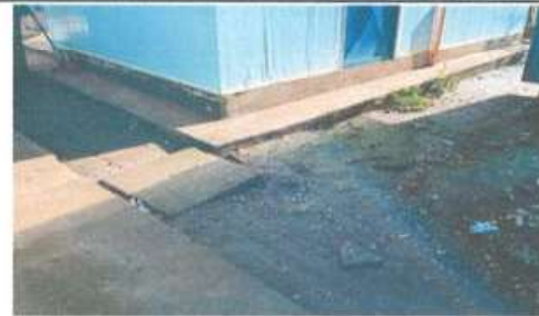
Foto 2: Reparacion de losa de concreto de patio
