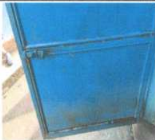
Foto 5: Sustitución de puertas metalicas de sanitario
