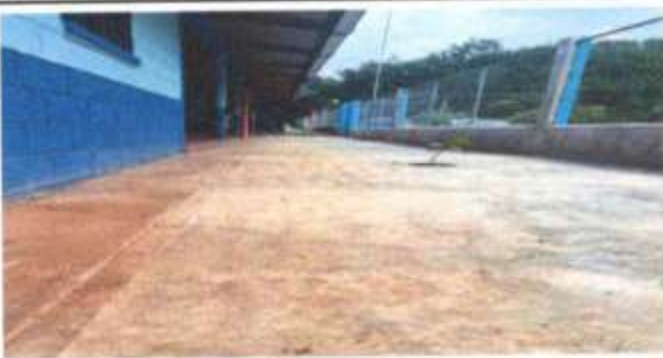
Foto 3: REPARACIÓN DE LOSA DE CONCRETO DE PATIO
