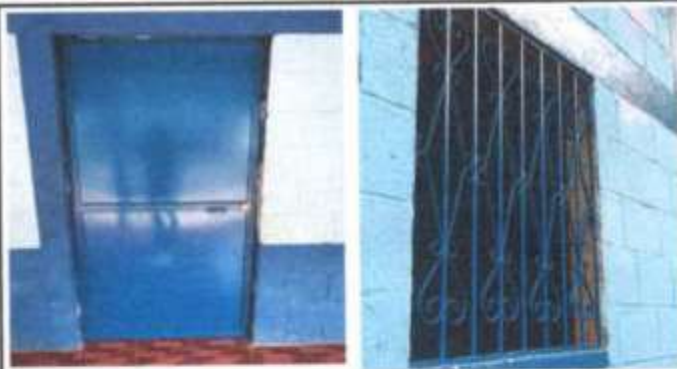
Foto 4: SUSTITUCIÓN DE BALCONES Y PUERTAS DE METAL
