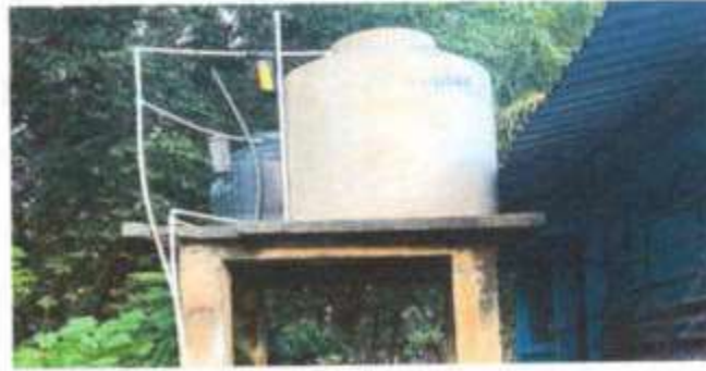
Foto 6: SUSTITUCION DE DEPOSITO DE AGUA DE 1100 LT.
