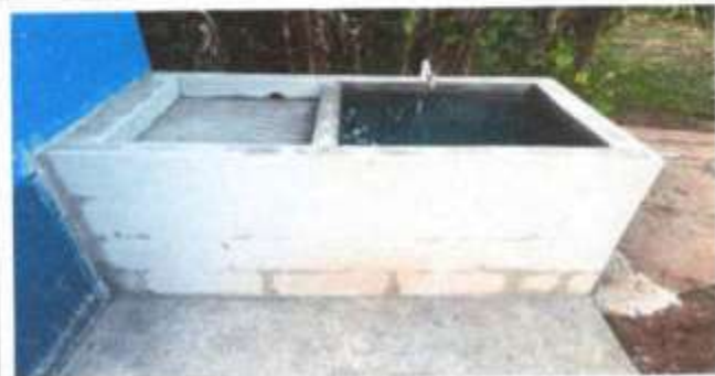
Foto 5: SUSTITUCIÓN DE PILA
