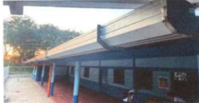
Foto 2: SUSTITUCION DE CANAL METALICO PARA AGUAS PLUVIALES
