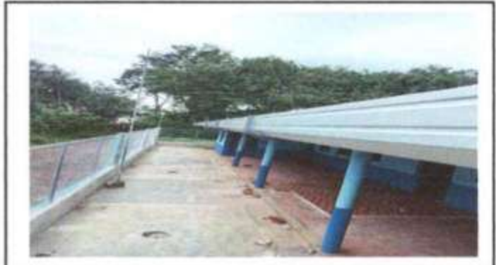
Foto 2: SUSTITUCION DE CANAL METALICO PARA AGUAS PLUVIALES
