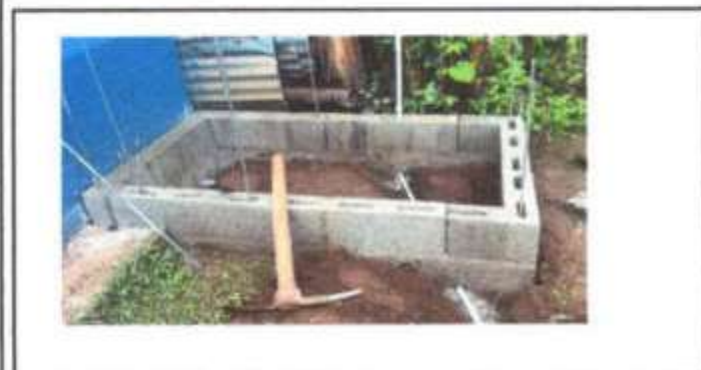
Foto 5: SUSTITUCIÓN DE PILA
