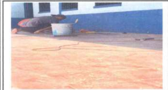
Foto 1: SUSTITUCIÓN DE PISO CERAMICO
