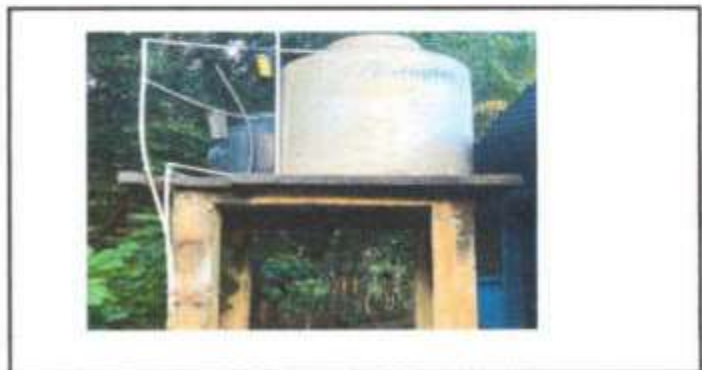
Foto 6: SUSTITUCION DE DEPOSITO DE AGUA DE 1100 LT.
