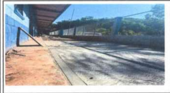
Foto 3: REPARACIÓN DE LOSA DE CONCRETO DE PATIO
