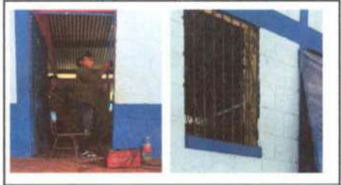
Foto 4: SUSTITUCIÓN DE BALCONES Y PUERTAS DE METAL
