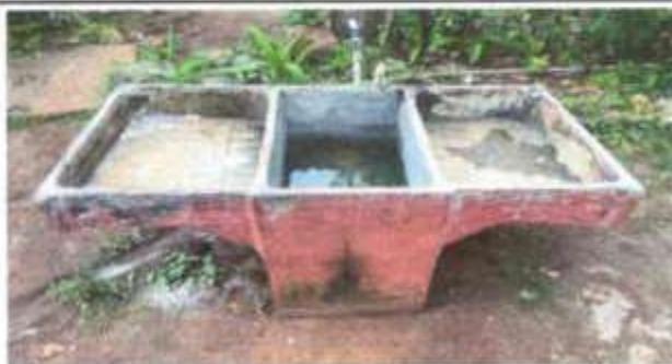
Foto 5: SUSTITUCIÓN DE PILA
