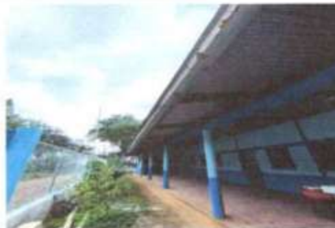
Foto 2: SUSTITUCION DE CANAL METALICO PARA AGUAS PLUVIALES
