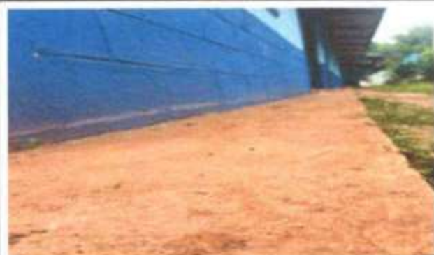
Foto 3: REPARACIÓN DE LOSA DE CONCRETO DE PATIO
