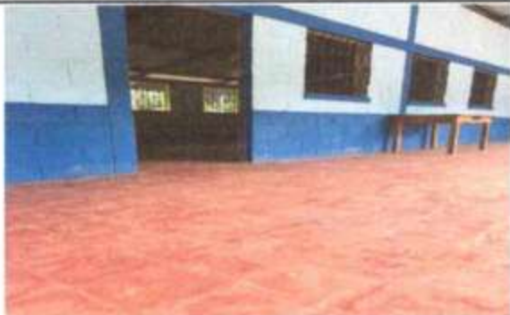
Foto 1: SUSTITUCIÓN DE PISO CERAMICO
