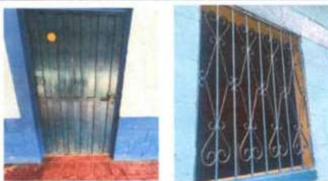
Foto 4: SUSTITUCIÓN DE BALCONES Y PUERTAS DE METAL
