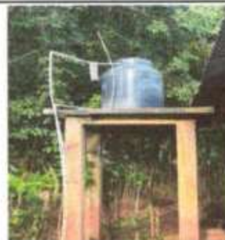
Foto 6: SUSTITUCION DE DEPOSITO DE AGUA DE 1100 LT.
