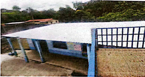
Foto 9: Suministro y Sustitución de lámina, por lamina troquelada Calibre 26 en aulas Finalizado
