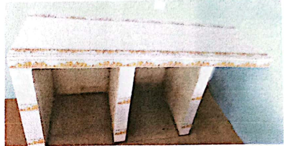
Foto 2: Suministro y Reparación de mesa de trabajo en cocina 2 x 0.60 x 0.90 M Finalizado
