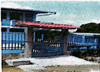
Foto 5: Suministro y Sustitución de gradas de concreto por rampa de concreto 2 x 2m Finalizado
