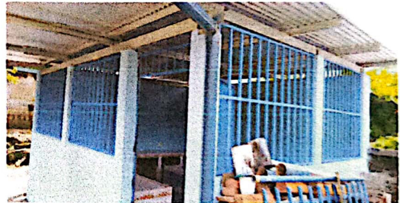
Foto 4: Suministro y Sustitución de malla por balcones de metal Finalizado
