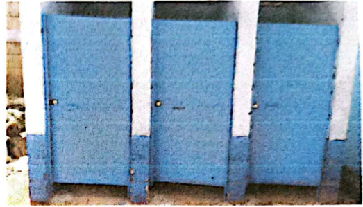
Foto 8: Suministro y Sustitución de puerta de metal en sanitarios Finalizado
