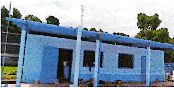
Foto 13: Suministro y Mantenimiento de 2 puertas de metal de dos aulas Finalizado
