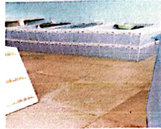
Foto 14: Suministro e Instalación de 20 mt de piso cerámico en cocina Finalizado
