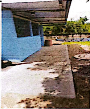
Foto 3: Suministro y Reparación de torta de concreto 11 X 1.25 M Finalizado
