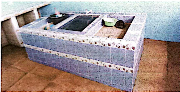
Foto 15: Suministro e Instalación de azulejo en pila de cocina Finalizado
