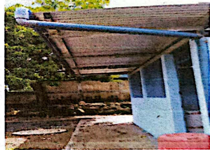
Foto 10: Suministro y sustitución de lámina acanalada por lámina acanalada c26 en cocina Finalizado
