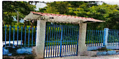
Foto 6: Suministro y Sustitución de portón de metal de 2 x 2.5 M Finalizado
