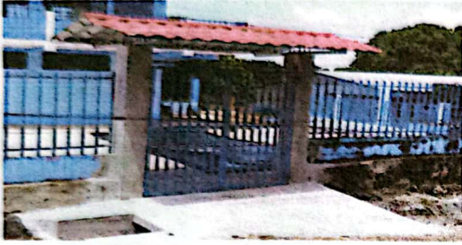
Foto 7: Suministro y Sustitución de Columnas de concreto de 0.2 X 0.2 X 2.5m Finalizado
