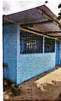
Foto 4: Suministro y Sustitución de malla por balcones de metal instalando
