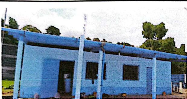
Foto 13: Suministro y Mantenimiento de 2 puertas de metal de dos aulas Finalizado
