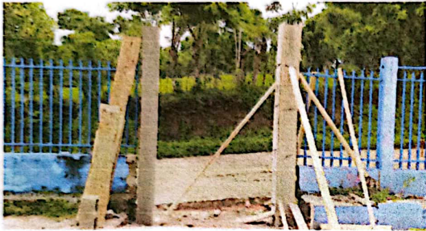
Foto 7: Suministro y Sustitución de Columnas de concreto de 0.2 X 0.2 X 2.5m En construcción
