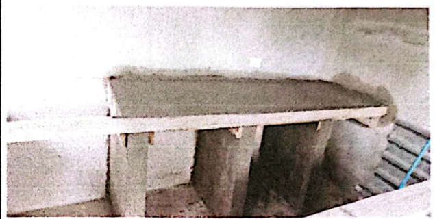
Foto 2: Suministro y Reparación de mesa de trabajo en cocina 2 x 0.80 x 0.90 M En construcción
