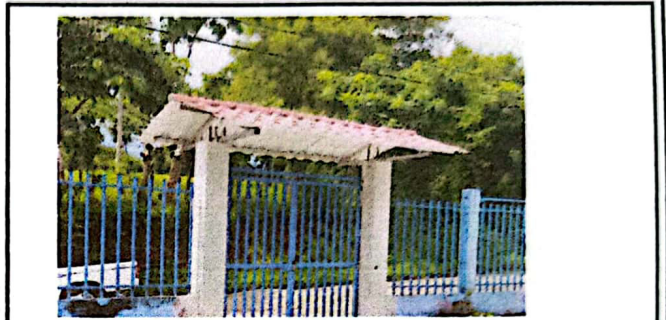
Foto 20: Suministro e instalación de techo para portón de entrada principal Finalizado
