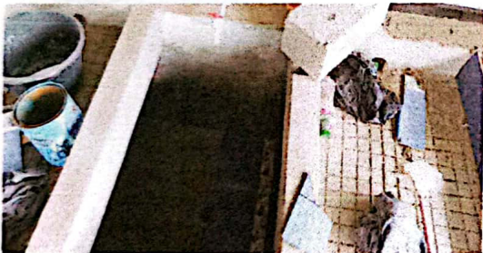
Foto 15: Suministro e Instalación de azulejo en pila de cocina instalando
