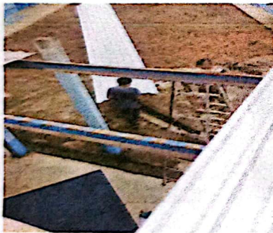
Foto 9: Suministro y Sustitución de lámina, por lámina troquelada Calibre 26 en aulas desinstalado techo
