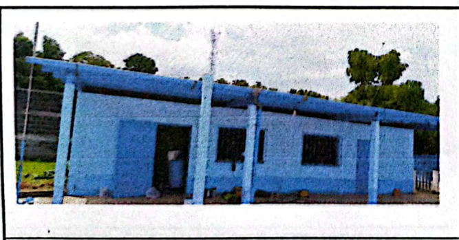
Foto 23: Suministro y Mantenimiento de pintura interior de cocina, 2 aulas y entrada principal Finalizado
