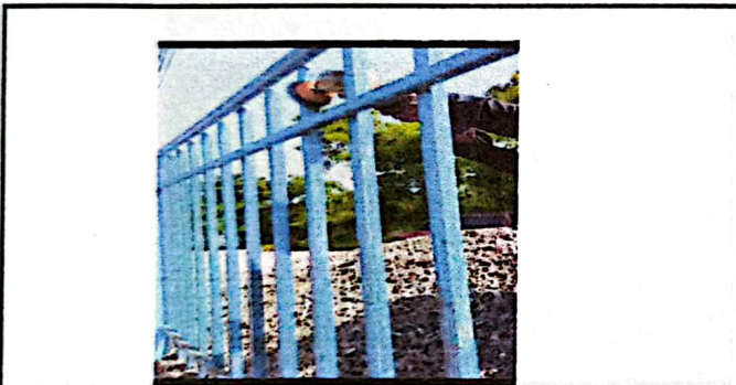
Foto 21: Suministro y Mantenimiento de estructura de metal tipo balcón en exterior Cepillandolo
