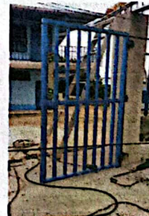
Foto 6: Suministro y Sustitución de portón de metal de 2 x 2.5 M instalando
