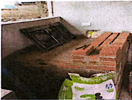
Foto 1: Suministro y Reparación de estufa en cocina con ladrillos y chimenea En construcción
