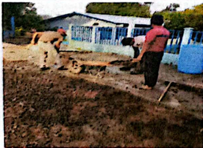
Foto 17: Suministro y sustitución de torta de cemento en patio 40 m2 levantando pavimento antiguo
