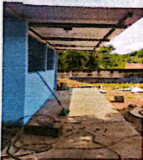
Foto 3: Suministro y Reparación de torta de concreto 11 X 1.25 M construido
