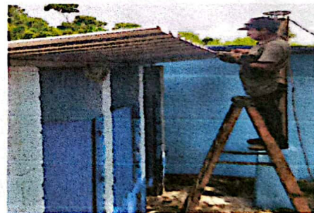
Foto 16: Suministro, desinstalación e instalación de lámina acanalada por lamina troquelada en sanitario instalado el techo
