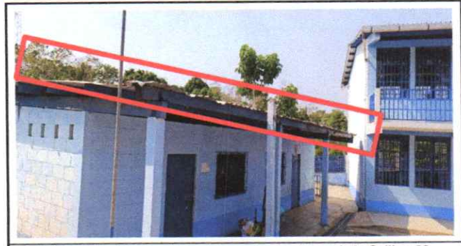
Suministro y Sustitucion de lamina, por lamina troquelada Calibre 26
