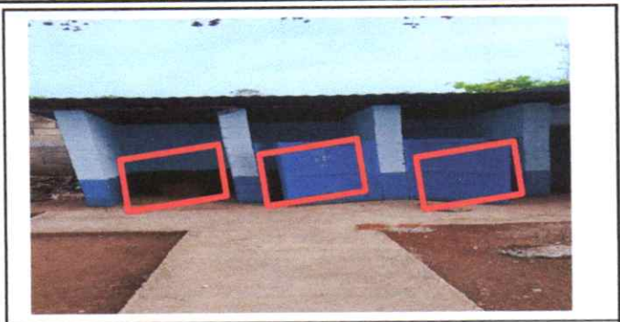
Suministro y Sustitucion de puerta de metal en sanitarios
