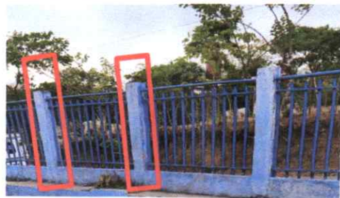
Suministro y Sustitucion de Columnas de concreto de 0.2 X 0.2 X 2.5m
