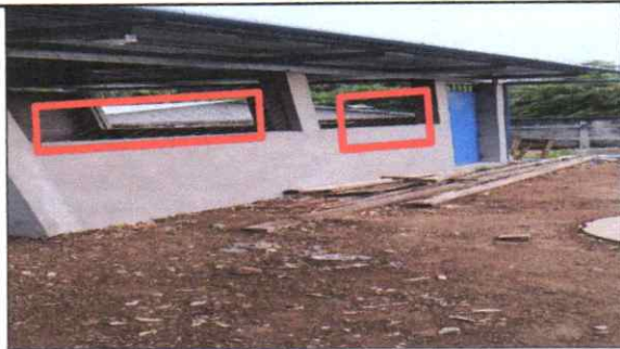
Suministro y Sustitucion de malla por balcones de metal
