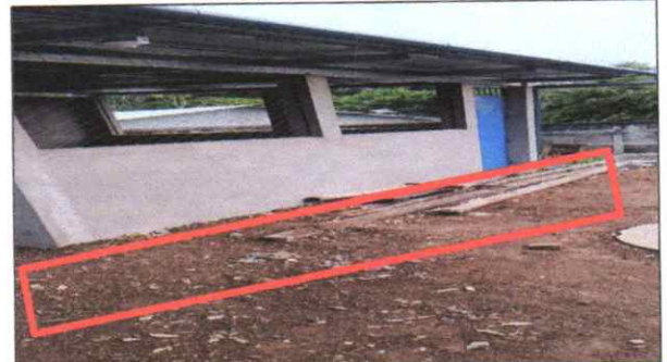
Suministro y Reparacion de torta de concreto 11 X 1.25 M
