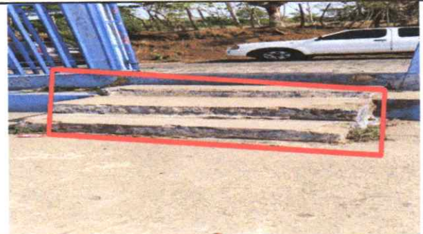
Suministro y Sustitucion de gradas de concreto por rampa de concreto 2 x 2m
