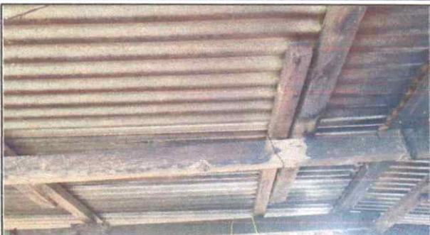
SUMINISTRO Y SUSTITUCION DE ESTRUCTURA DE SOPORTE DE MADERA POR METAL
