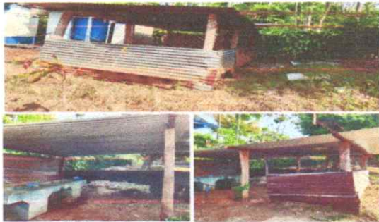
INSTALACIÓN DE MURO DE CONCRETO EN PILAS, INSTALACIÓN DE TORTA DE CONCRETO Y SUSTITUCIÓN DE ESTRUCTURA Y LAMINA
