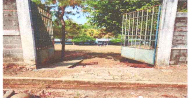
INSTALACIÓN DE ESTRUCTURA DE METAL Y LÁMINA EN PORTON DE INGRESO, MANTENIMIENTO DE PORTON
