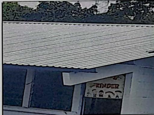
Sustitución de lámina en módulo de 3 aulas
