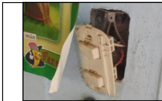
Foto 5: SUMINISTRO E INSTALACION DE INTERRUPTORES DOBLES
