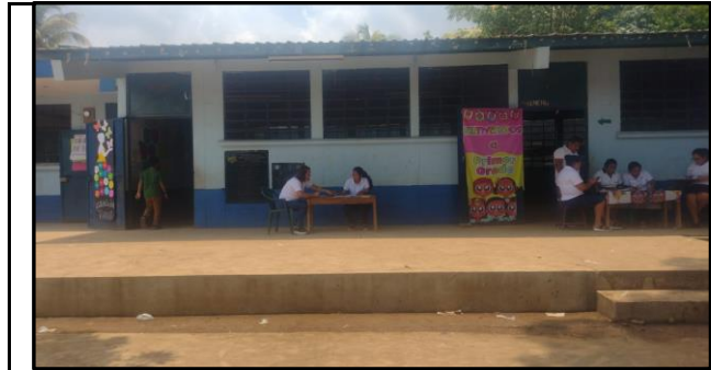
foto 1: SUMINISTRO E INSTALACION DE LAMINA TROQUELADA DE ALUZINC CAL. 26
