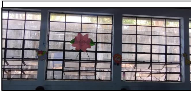
Foto 3: SUMINISTRO Y MANTENIMIENTO DE ESTRUCTURA DE METAL DE VENTANA
