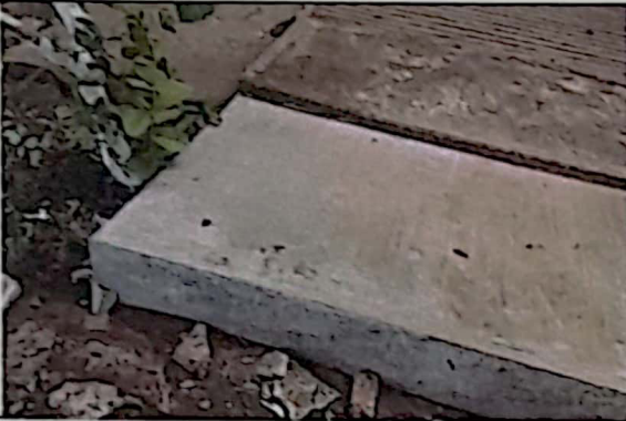
Fundición de encaminamiento área de cocina
