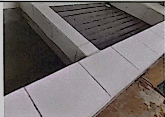
Sustitución de pilas de 3.10*0.90*0.85M de 2 lavaderos + azulejo
