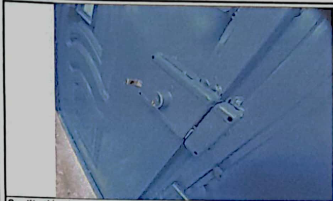
Sustitución de portón de ingreso primario y secundario
