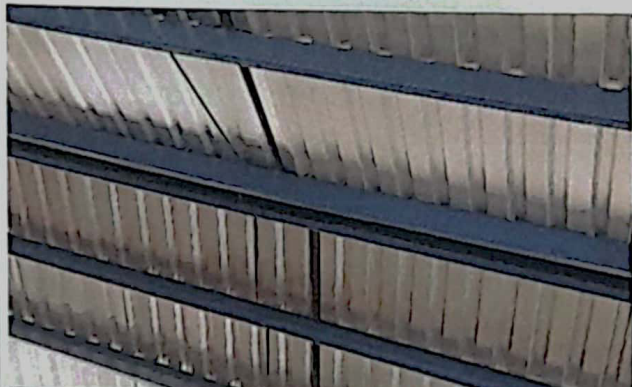
Reparación y mantenimiento de estructura metálica en módulo de 1 aula
