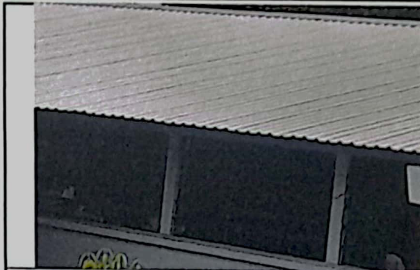
Sustitución de lámina en módulo de 1 aula
