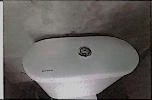
Cambio de inodoros y accesorios
