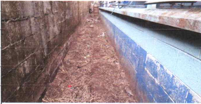
Suministro y sustitución de Banqueta de concreto de protección módulo 1
