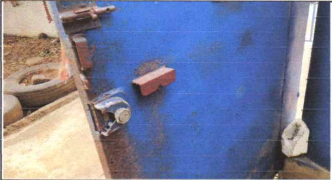
Suministro y Sustitución de portón de metal de ingreso primario y secundario
