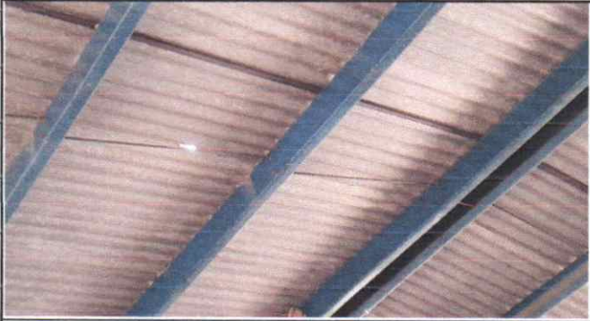
Suministro y mantenimiento de estructura metálica en módulo de aula
