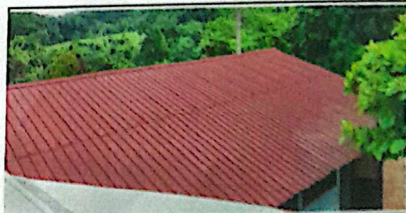
Sustitución de lámina troquelada aluzinc calibre 26
