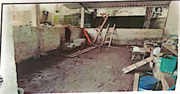
Sustitución de torta de concreto en modulo de cocina
