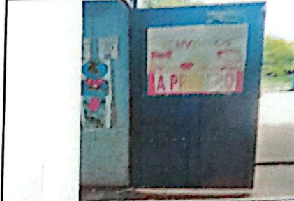
Suministro y sustitucion puertas de metal con chapa y ale modulo de aulas.
