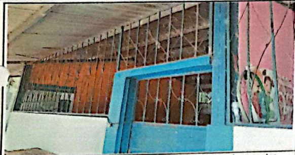
Suministro e instalación de balcones de metal modulo de aulas y cocina
