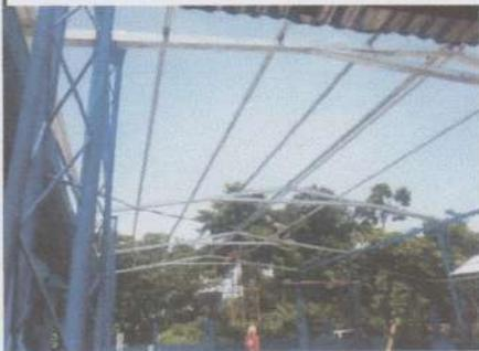
SUMINISTRO Y SUSTITUCIÓN DE COLUMNAS POR COLUMNAS TRIANGULARES DE METAL
