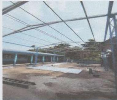
SUMINISTRO Y SUSTITUCIÓN DE ESTRUCTURA DE SOPORTE DE MADERA POR METAL
