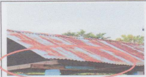
SUMINISTRO Y SUSTITUCION DE COLUMNAS POR COLUMNAS TRIANGULARES DE METAL
