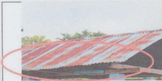
SUMINISTRO Y SUSTITUCION DE CANAL DE METAL
