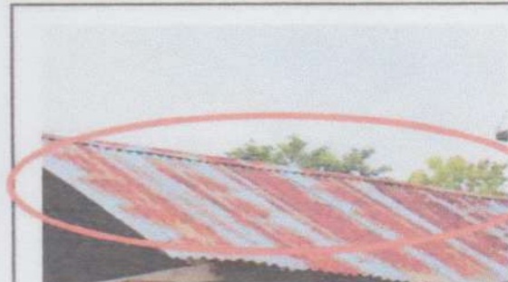
SUMINISTRO Y SUSTITUCION DE LAMINA, POR LAMINA TROQUELADA CALIBRE 26
