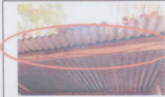
SUMINISTRO Y SUSTITUCION DE ESTRUCTURA DE SOPORTE DE MADERA POR METAL
